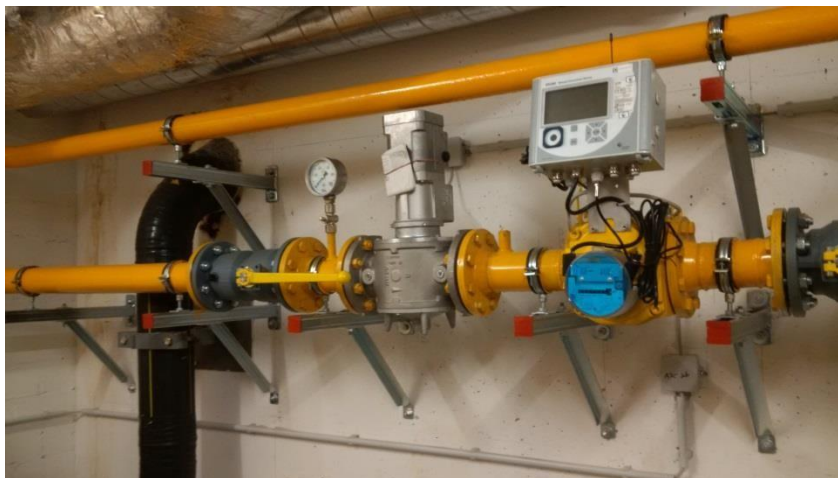
Abbildung 7 Drehkolbenzähler mit Registrierender Lastgangmessung
