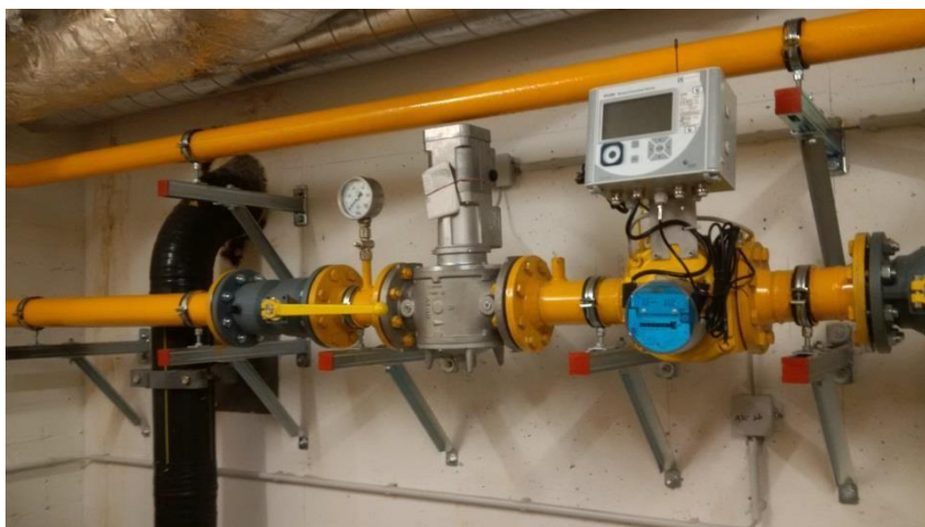
Abbildung 7 Drehkolbenzähler mit Registrierender Lastgangmessung
