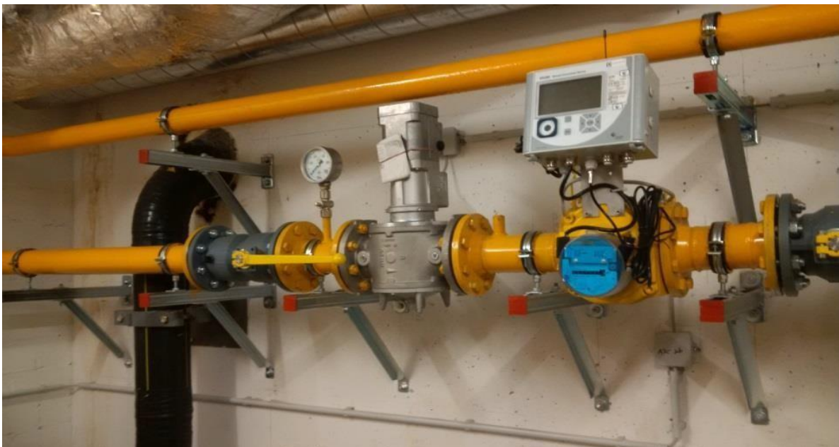
Abbildung 11 Drehkolbenzähler mit Registrierender Lastgangmessung
