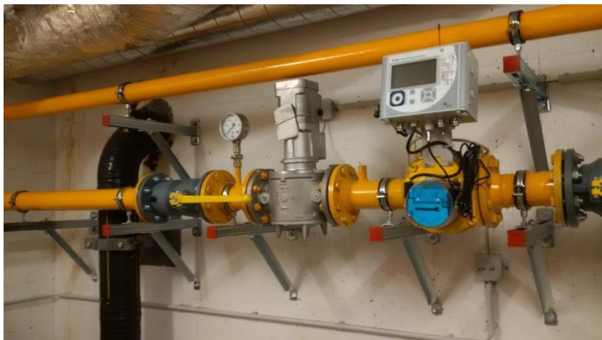
Abbildung 7 Drehkolbenzähler mit Registrierender Lastgangmessung
